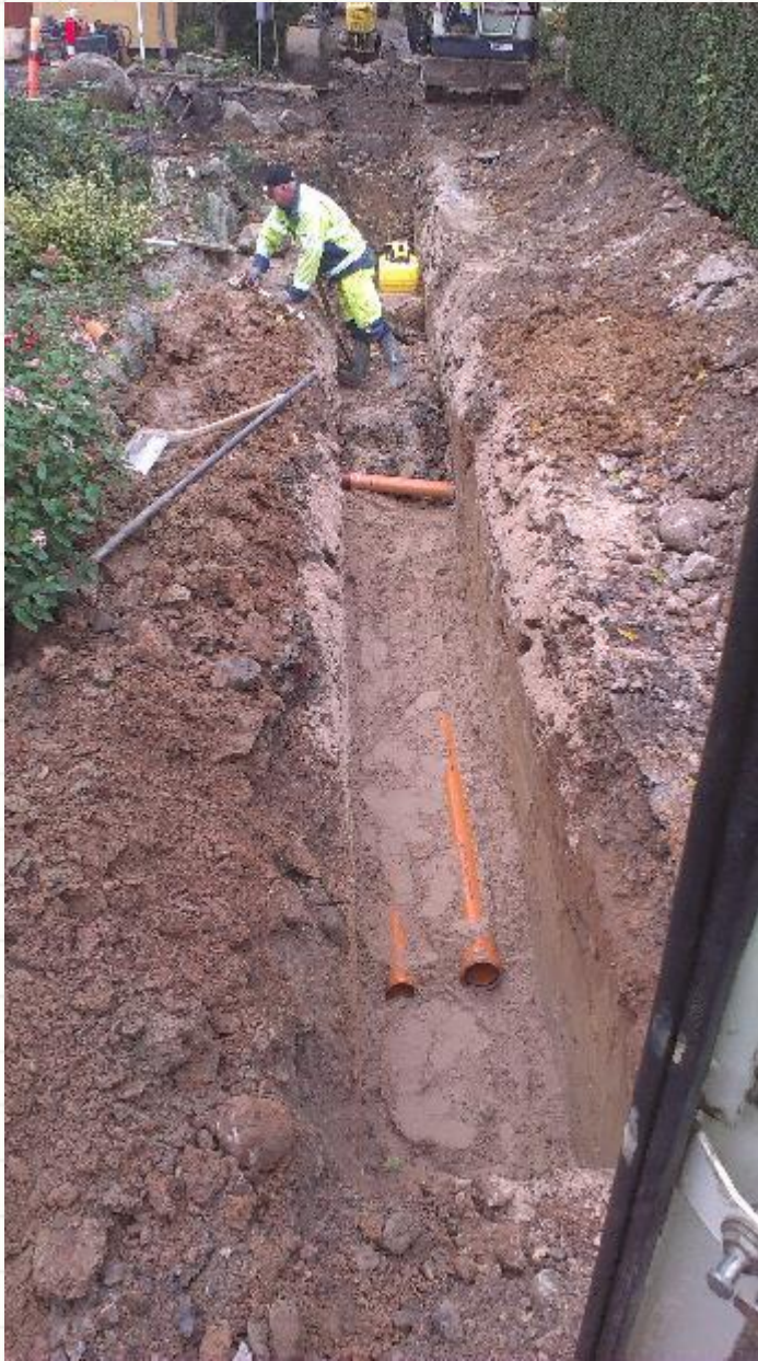
Ved separatkloak lægges to rør – et til regnvand og et til spildevand
